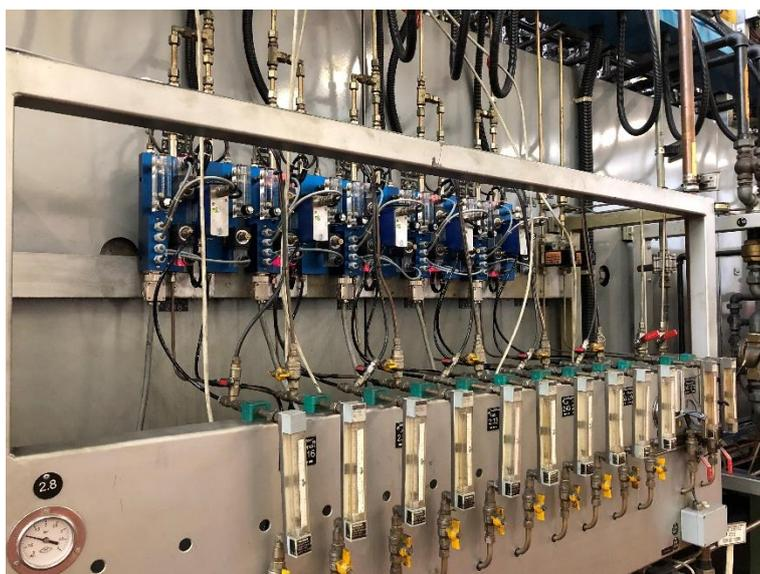
Régulation de 5 zones %C via DM3 sur une ligne de TTH
